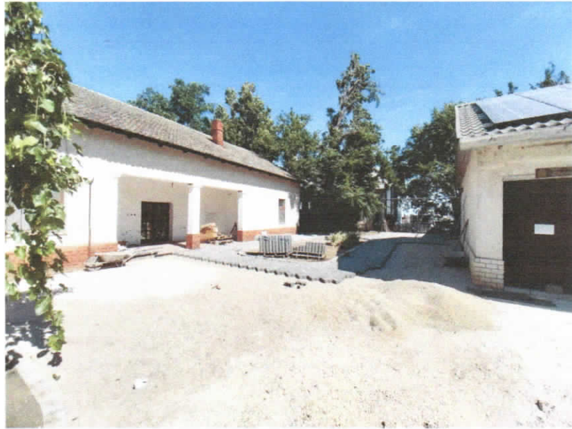
9. ábra Építési munkálatok.
