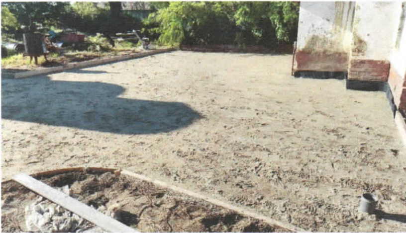
6. ábra Építési munkálatok.
