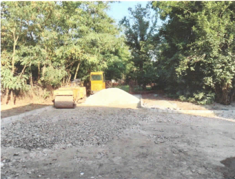
8. ábra Építési munkálatok.
