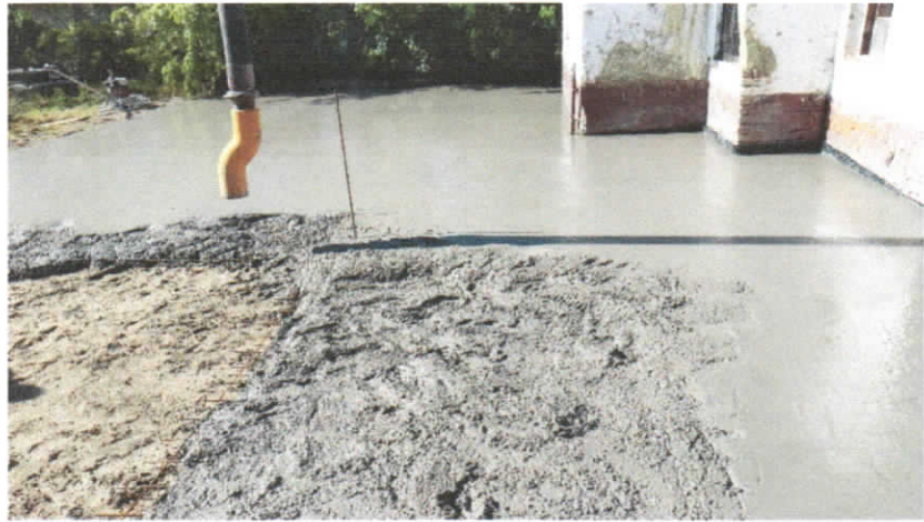
7. ábra Építési munkálatok.
